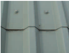
Colorcoat HPS200 Ultra® med Galvalloy® tak etter 7 år
